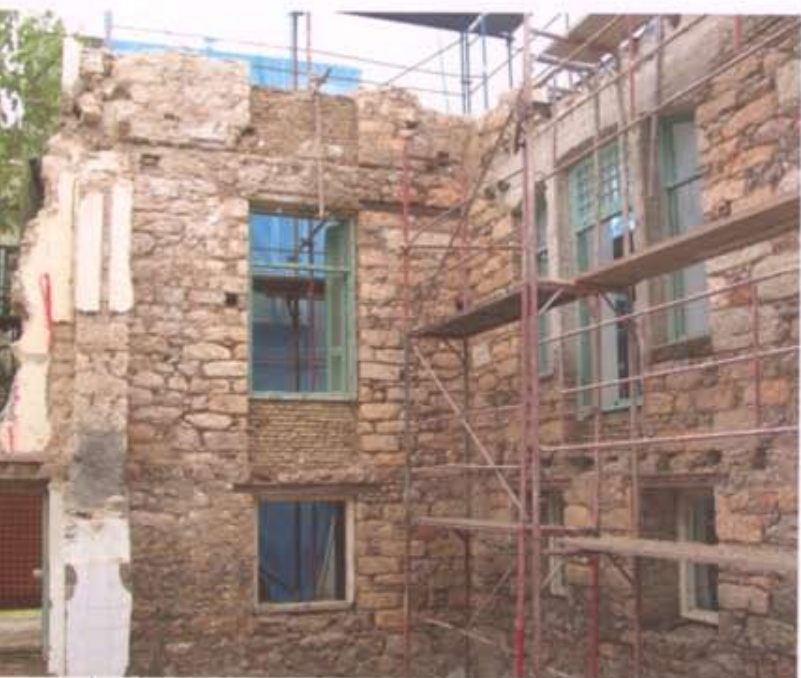
1 Το κτίριο πριν από την αποκατάσταση. 2 Το κτίριο στη φάση της αποκατάστασης. 3 (Απέναντι σελίδα) Μέρος του τοίχου που αποκαλύφθηκε και συντηρήθηκε.
